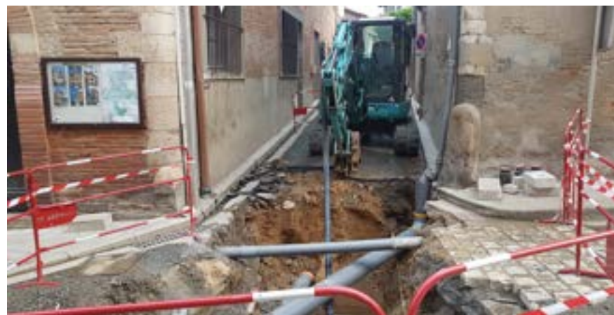
Travaux du réseau d'assainissement dans la rue de l'Ort.
