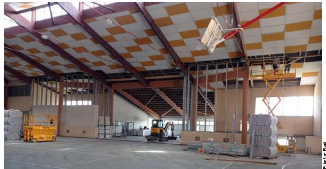
Pose des cloisons entre le gymnase et l'ancien espace boxe.
