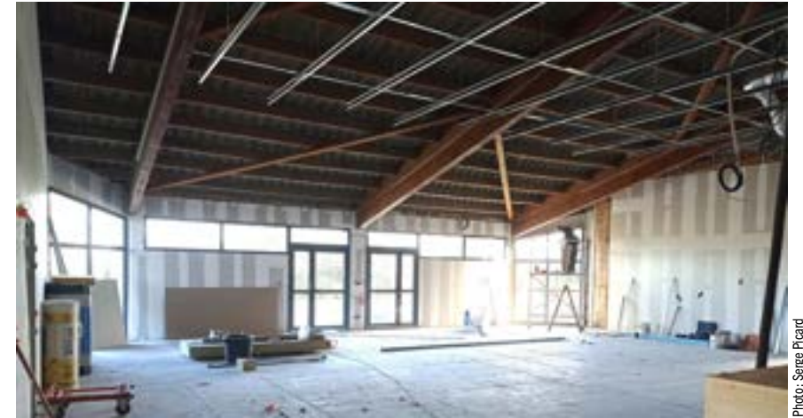
Changement des menuiseries isolation des murs.
